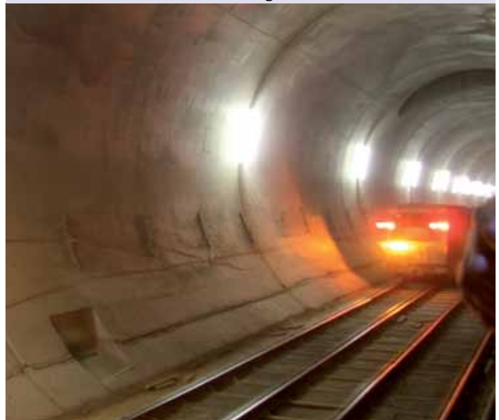
Provisorische Baubeleuchtung im Gotthard Basistunnel
